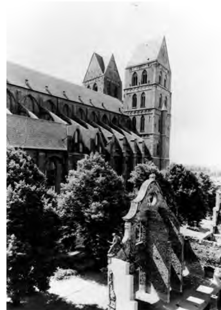
Abb. 3.1.1.j: Blick hinter die abgestützte Fassade
